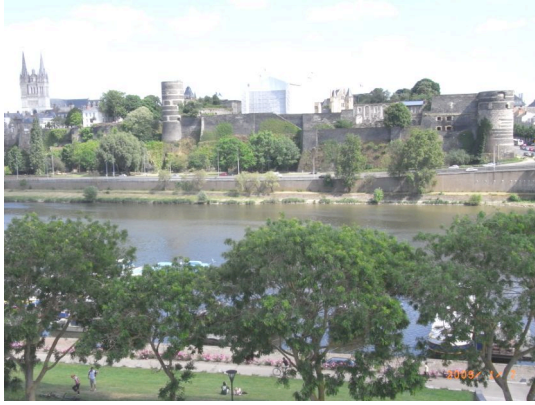
(Le Logis Royal après un incendie en janvier 2009 a été recouvert d'un « imperméable » en attendant la réfection de la toiture.
